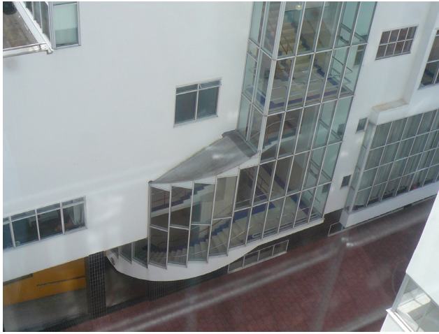
Abb. 13: Treppenhausfassade Van Nelle, Fotografie Katja Marx 2015
