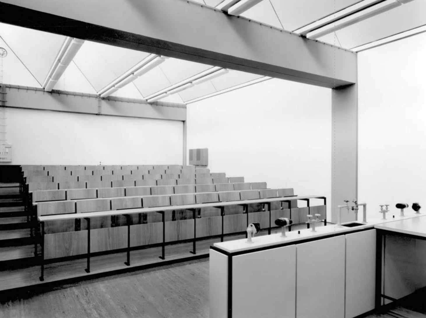
46 Kleiner Hörsaal im Laborgebäude, Foto 1967
